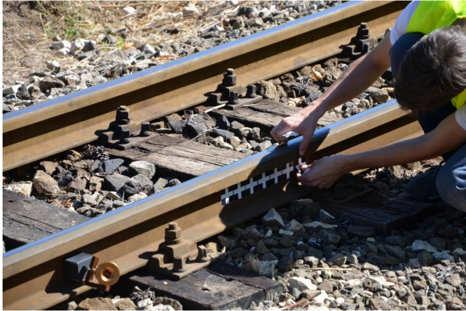
27. ábra: A matricák felhelyezése a mérési szelvényben
