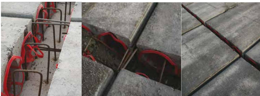
13.ábra: Betonozás előtti ellenőrzés [6]
