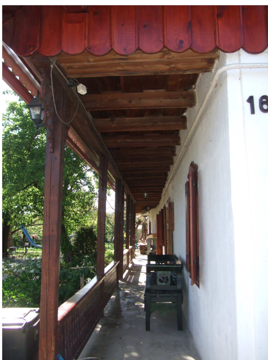
27. ábra: A fa oszlopokkal támasztott nyitott tornác
