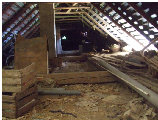
36. ábra: Torokgerendás fedélszék
