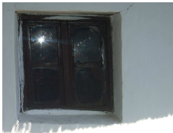
18. ábra: Az ablak deformációja (saját fotó)
