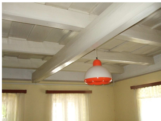
35. ábra: Látszó fa gerendafödém mestergerendával megerősítve
