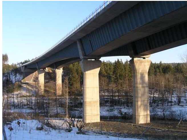
21. ábra: Altwipfergrund híd [6]
