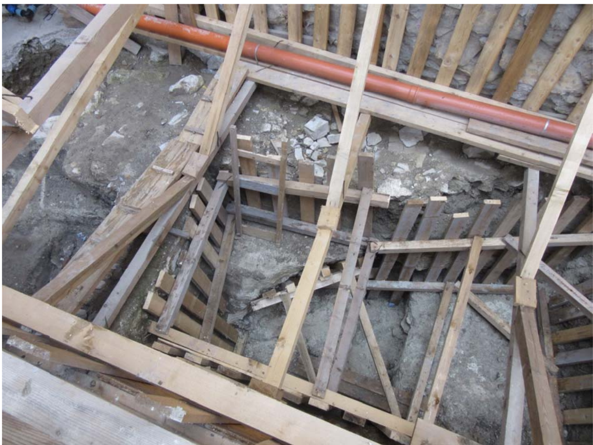
2. ábra - Feltárt gödrök kidúcolva, történelmi falazatok
