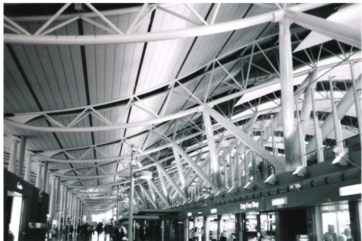
3. ábra - Kansai repülőtér (Japán) termináljának háromöví rácsos főtartói
