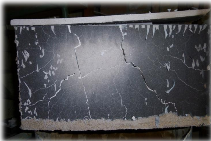
4.18. ábra: A próbadohoz repedései
