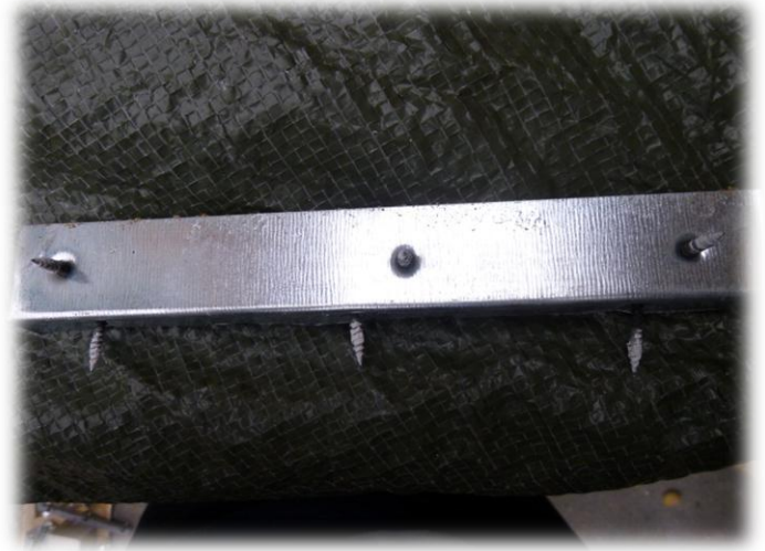
4.38. ábra Normál gipszkarton doboz rögzítő eleme
