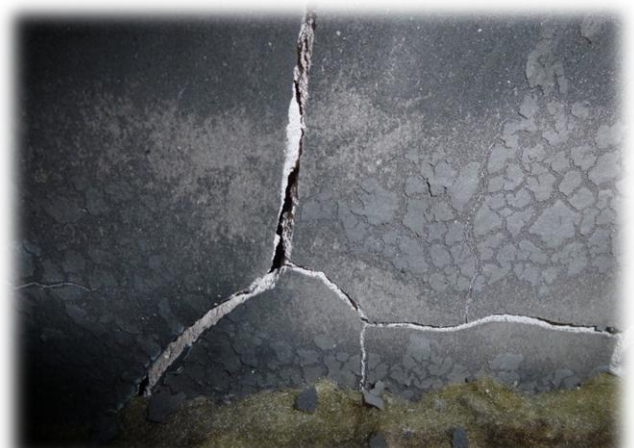
4.20. ábra: A gipszkarton repedései
