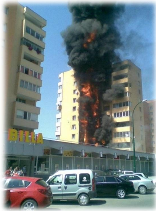
2.14. ábra: Lángoló EPS szigetelés Marosvásárhelyen [17]
