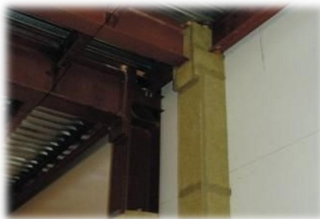
2. 10. ábra Acél gerenda tűzvédelme (gyakorlati megvalósítás) [11]
