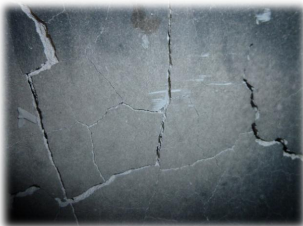
4.20. ábra: A gipszkarton repedései
