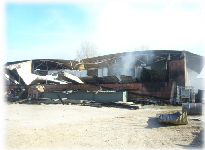
2.1. ábra Károsodott acélszerkezetek [2]
