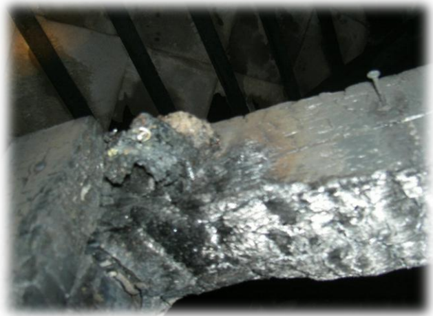
2.3. ábra: Keresztmetszet csökkenés [2]
