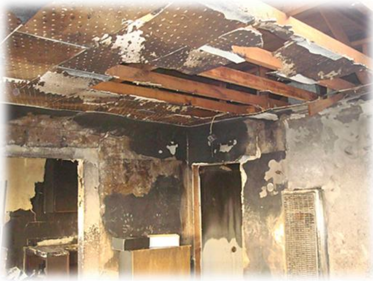
2.5. ábra: Károsodott gipszkarton álmennyezet és fal [4]
