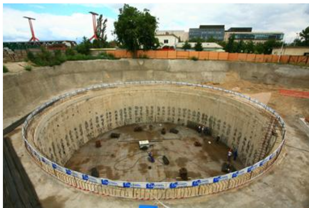
2.1 fénykép: Résfalas munkatérhatárolás [BAUER Magyarország fényképe webről]
