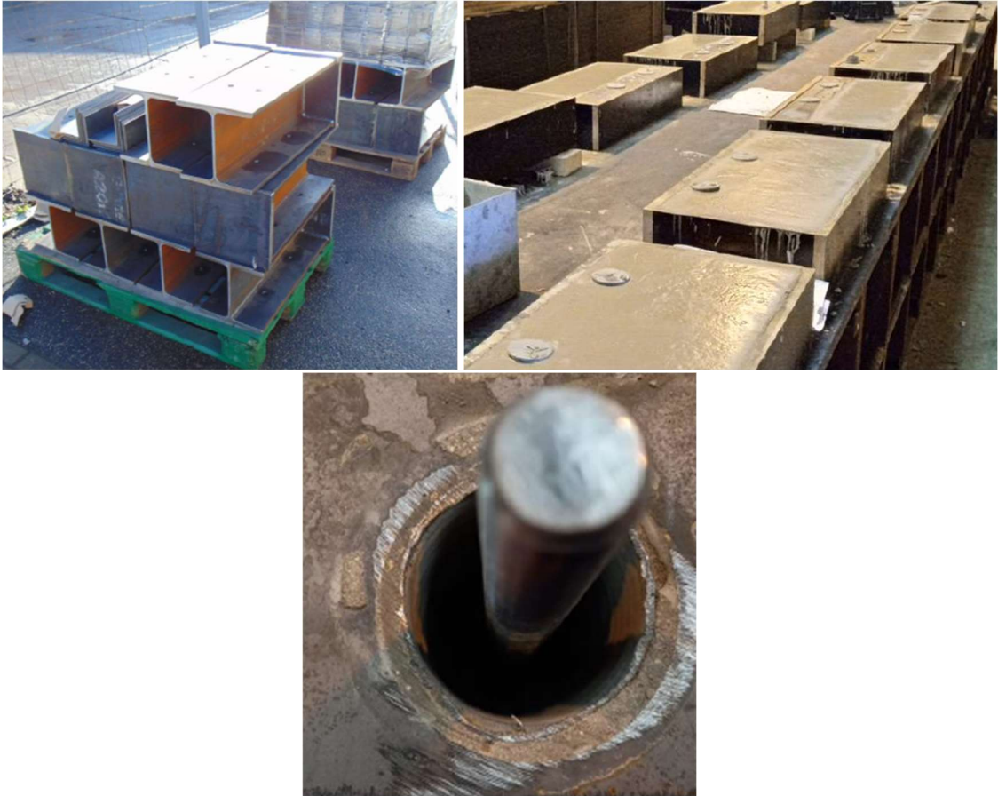
4.5. ábra: Kivitelezés munkálatai [16]
