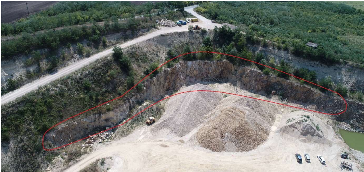
3. ábra: A vizsgált falszakasz
