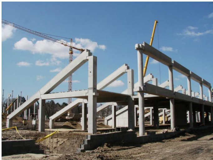
3.35 ábra: A debreceni Nagyerdei Stadion vázszerkezetének építése [29]
