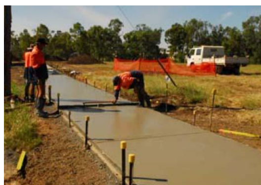
3.37 ábra: Az ausztrál bicikliút építése [30]
