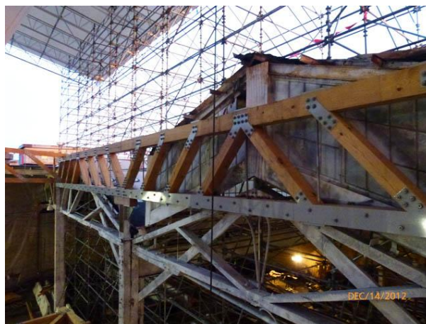
3.1 ábra: Faszervezetek rögzítése a magasépítésben (www1)
