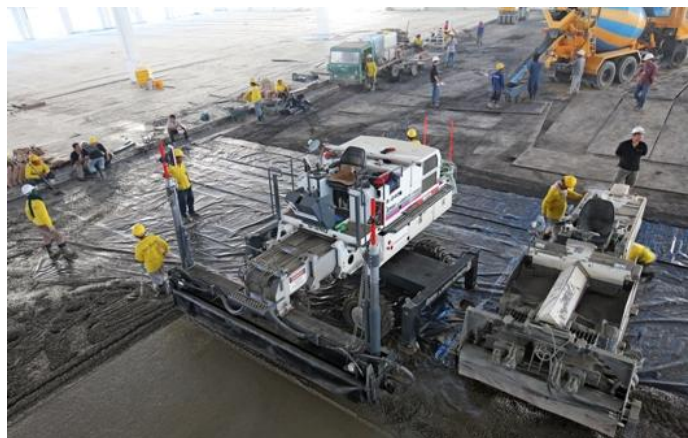
3.30 ábra: Acél szálerősítésű padló készítése, Thaiföld (www13)
