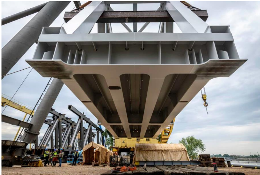
2. 7. 2. ábra. Déli összekötő vasúti Duna-híd – gyártási egység a csepeli előszerelő telepen
