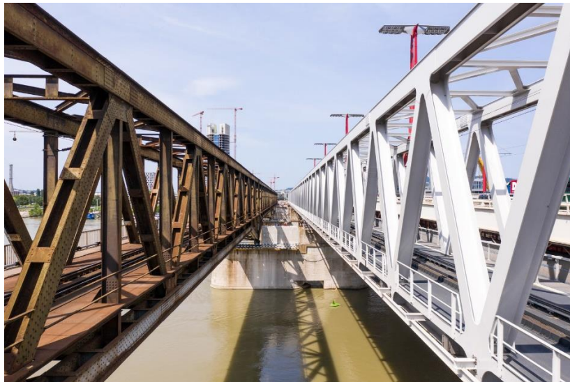
2. 7. 3. ábra. Déli összekötő vasúti Duna-híd: új és a régi felszerkezet
