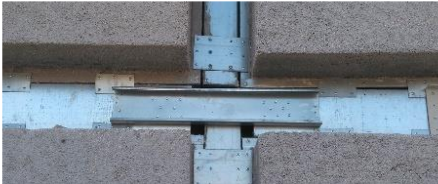
31. ábra Megerősített csomópont az épület két traktusa között (T3 épület)
