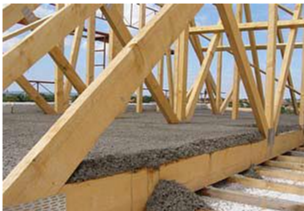
5. ábra PSC alkalmazásai: nem teherhordó hőszigetelő födém (bal) [10], födém rétegrénd PSC kitöltéssel (jobb) [9]
