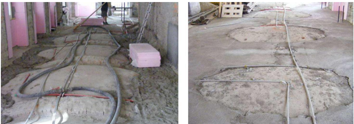
6. ábra Műemlék épület boltozatának feltöltése [7]
