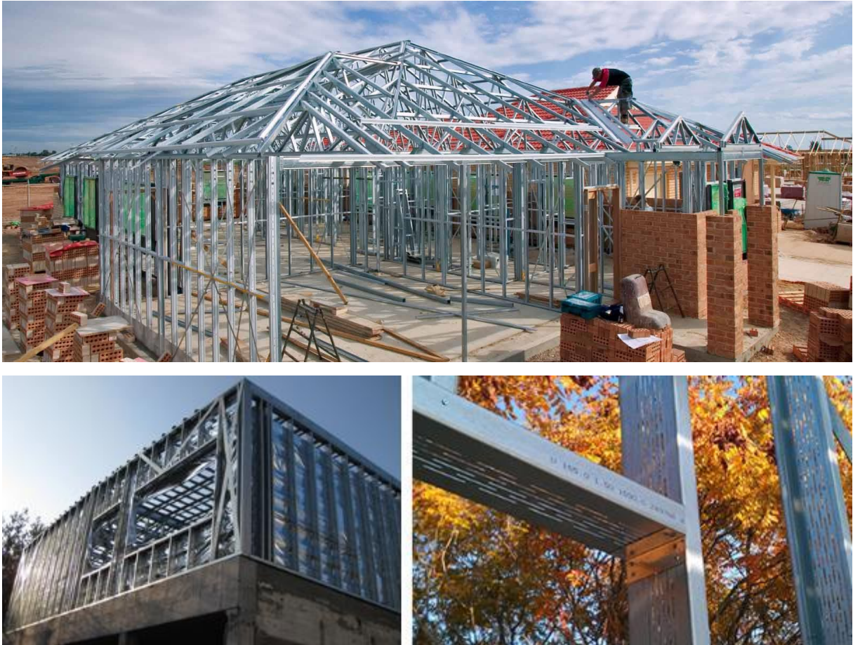
1. ábra Vékonyfalú szelvények alkalmazása [2] [3]
