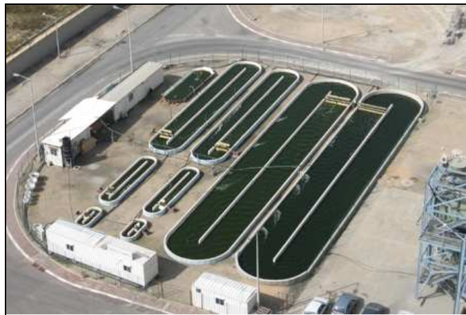
2. ábra Nyílt medencés technológia, San Diego, Kalifornia
