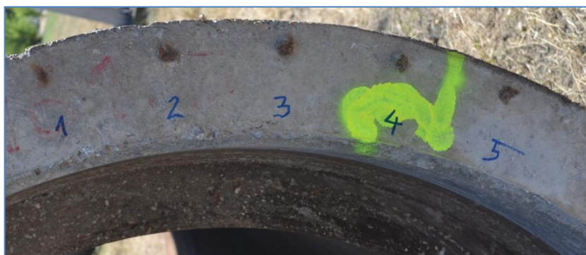
6.19. ábra: II. számú cső bütüs felületén tapasztalt rozsdafoltok (Kép készült: 2013. 07. 22.)
