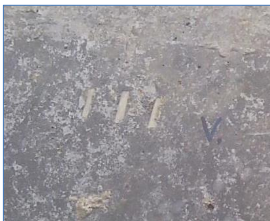
6.6. ábra: Feszítőhuzal távtartója a beton felületén (Kép készült: 2012. 07. 16.)
