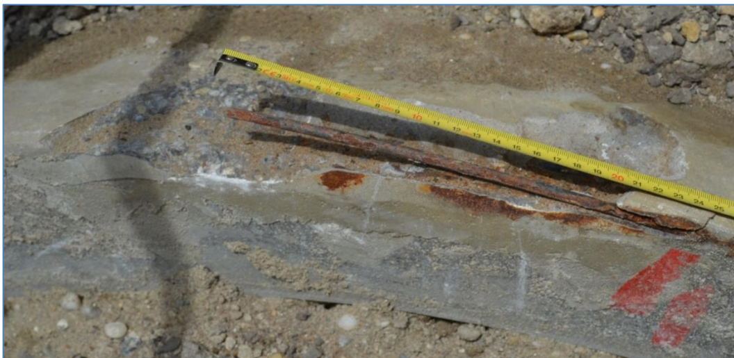
6.14. ábra: Tokvégnél kiálló feszítőhuzal (Kép készült: 2013. 05. 06.)
