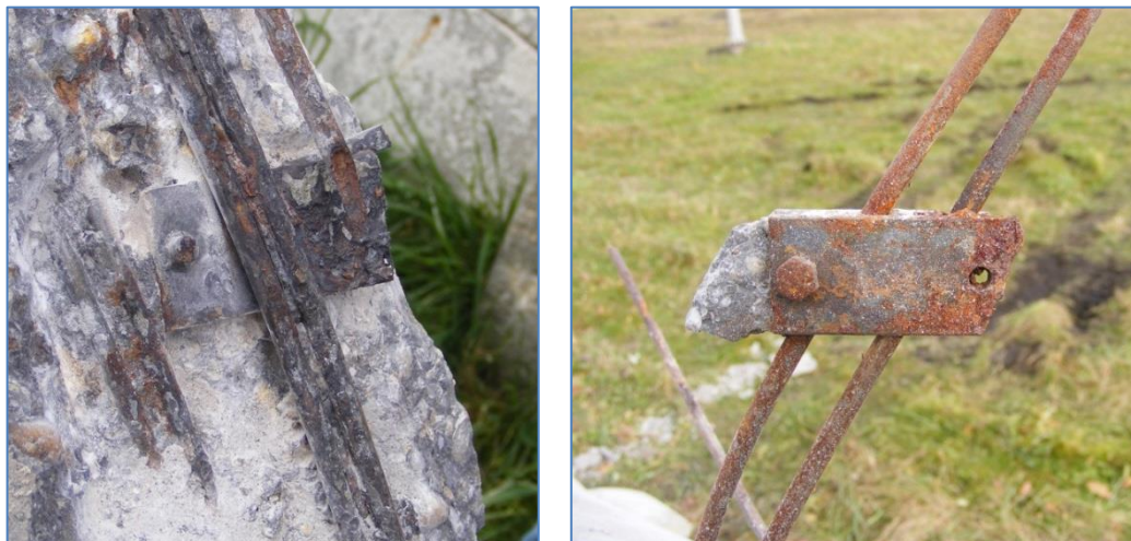
6.22. ábra: Spirálisan futó feszítőbetét véglehorgonyozása (Képek készültek: 2010. 11. 04.)
