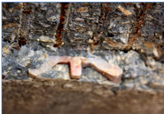
2.7. ábra: Spirális feszítőhuzal pozicionálásához használt műanyag távtartó (Kép készült: 2012. 07. 06.)
