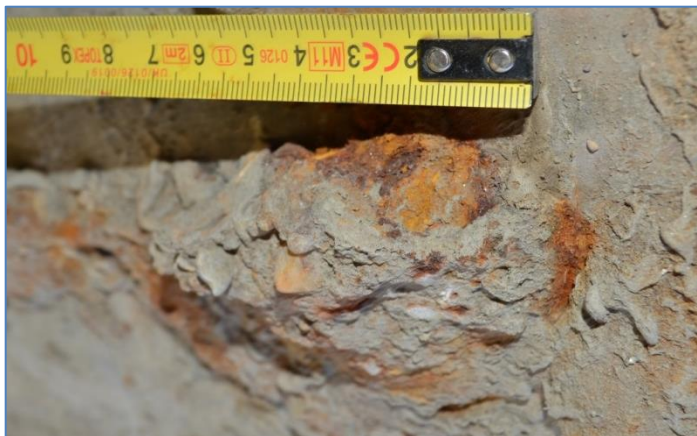
6.4. ábra: Zsaluillesztésnél észlelt talajjal keveredett rozsdatermék (Kép készült: 2013. 07. 17.)
