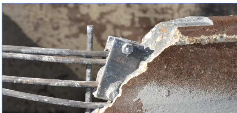
2.10. ábra: Sentab cső spirálisan futó feszítőhuzal végének rögzítő eleme (Kép készült: 2013. 10. 08.)
