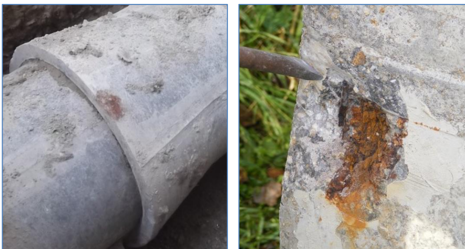
6.5. ábra: Spirálisan futó feszítőbetét véglehorgonyzásának hibája (Bal oldali kép készült: 2012. 07. 02., jobb oldali kép készült: 2010. 11. 04.)
