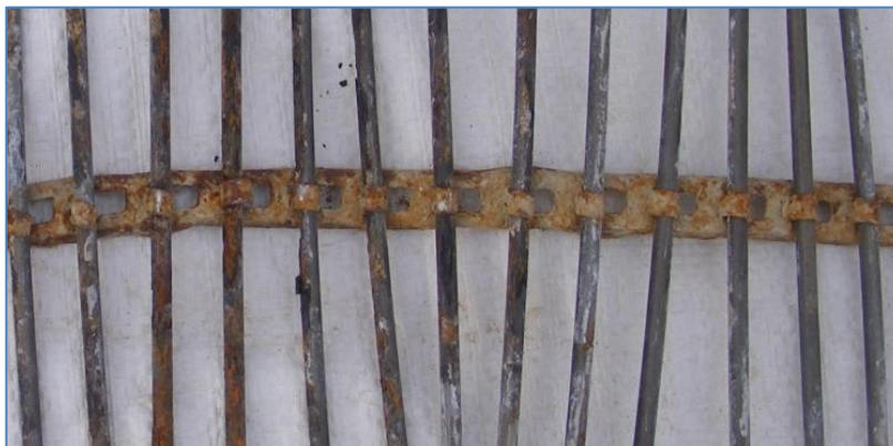
2.5. ábra: Az egyik helyszíni vizsgálatom során feltárt spirálhuzalrendező lécs (Kép készült: 2010. 11. 04.)
