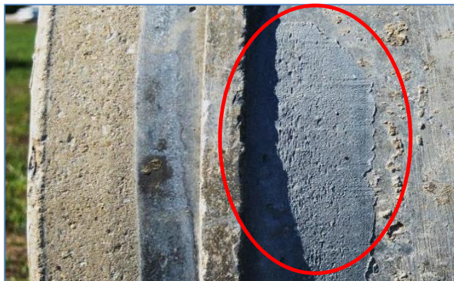
6.12. ábra: Cső felületén észlelt javítás (Kép készült: 2012. 08. 09.)
