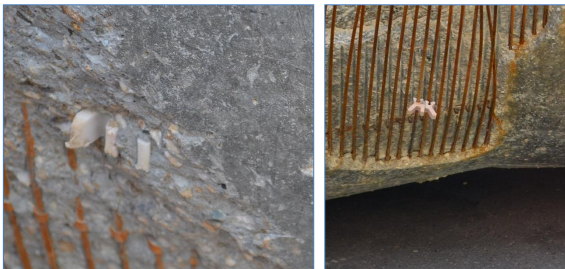
6.23. ábra: Csőtörés során szabaddá vált műanyag távtartók környezete (Képek készültek: 2012. 08. 03.)
