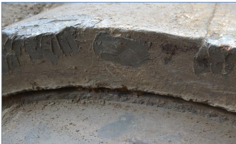
6.13. ábra: Cső bütös felületének és tokvég palástjának javítása (Kép készült: 2012. 06. 12.)
