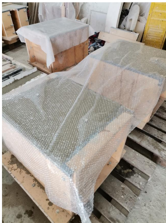
29. ábra: Beton utókezelése
