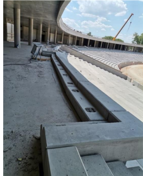
11. ábra: Nemzeti Atlétikai Központ előregyártott vasbeton elemei
