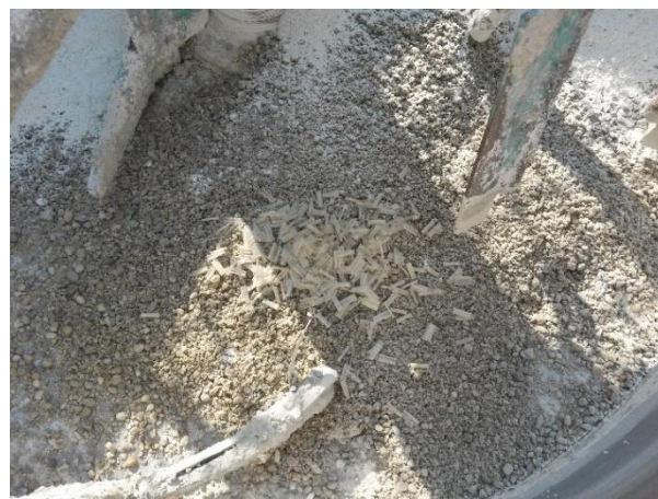
42. ábra: Műanyag szálak adagolása a betonba
