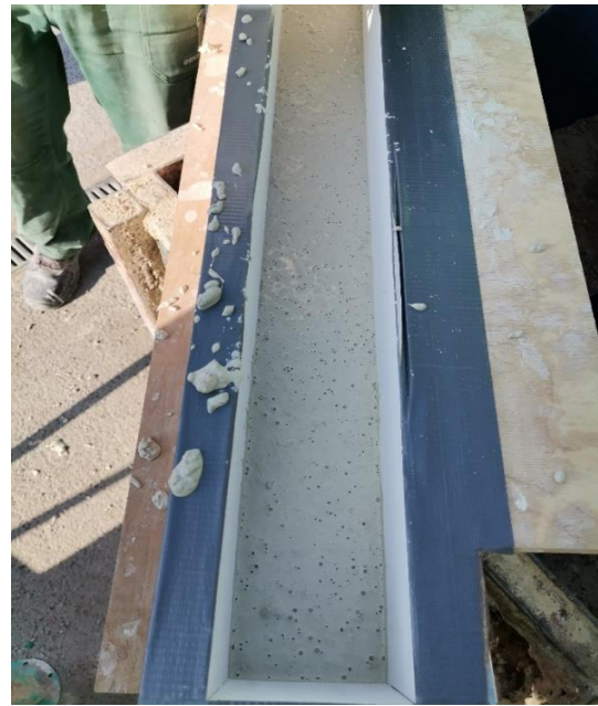
23. ábra: Légtelenedés közben tömörödik a beton
