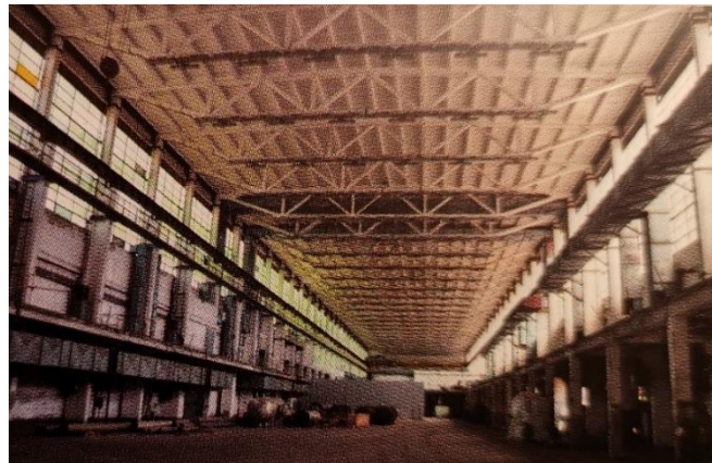
9. ábra: TVK Műtrágyagyár kompresszorcsarnokában látszóbeton rácsostartó [3]
