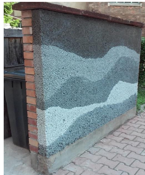
7. ábra: Szemcsehézagos látszóbeton fal
