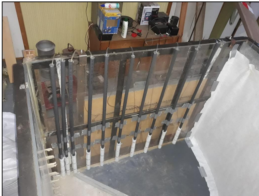
3. kép: Megfigyelőkutak beépítése
