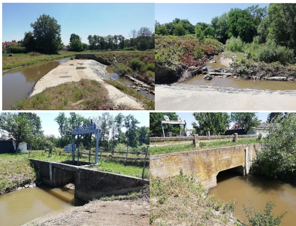
8. ábra Az oldalbukó és alvize (felső sor) illetve a zsilip felvízi és alvízi oldala (alsó sor)
