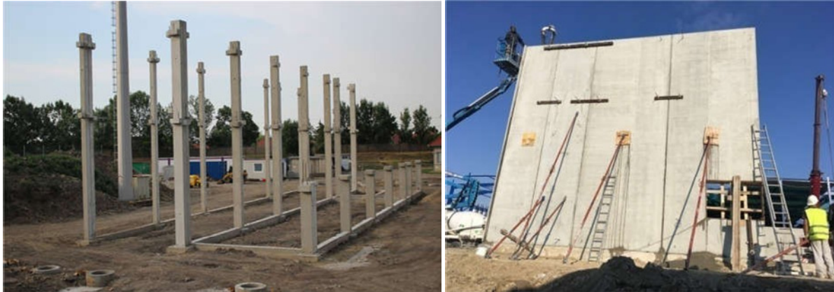
2. ábra: Előregyártott oszlopok, illetve falak építés közben [26], [27]
