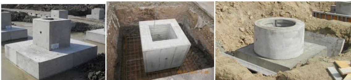
1. ábra: Az említett kehelyalapozási fajták: kehelynyak egyben az alaplemezzel előregyártva, előregyártott kehelynyak monolit alaplemezzel négyzet illetve kerek kivitelben [24], [25],[26]
