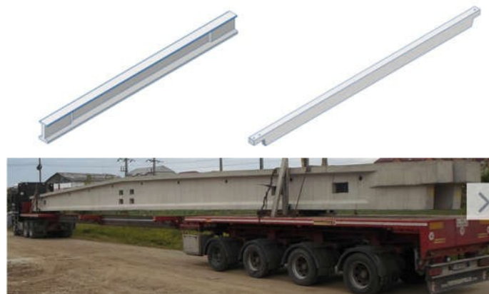
12. ábra: Néhány főtartó és egy elkészült gerenda szállítás közben: ASA [25]
