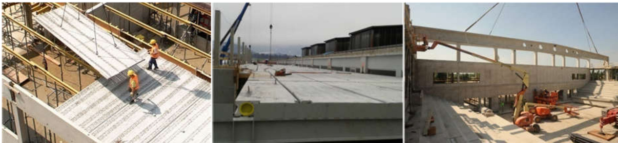
3. ábra: Különböző előregyártott födémpanelek, feszített vasbeton főtartó gerendák építés közbeni állapotban [24], [26], [27]
