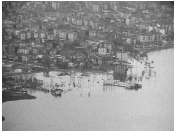
31. ábra Talajfolyósodás következtében megsüllyedt, majd víz alá került terület. Gölcük, Törökország (1999)
