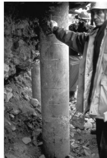
36. ábra: Az oldalirányú elmozdulások következtében tönkrement cölöpök. Kobe, Japán (1995)
