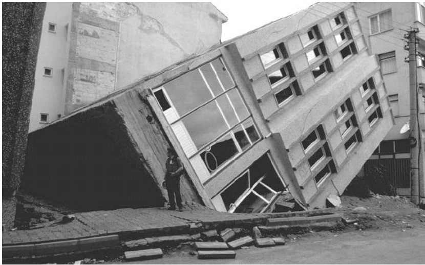
35. ábra: Talajfolyósodás okozta szilárdságvesztés miatt felborult építmény. Adapazari, Törökország (1999)
