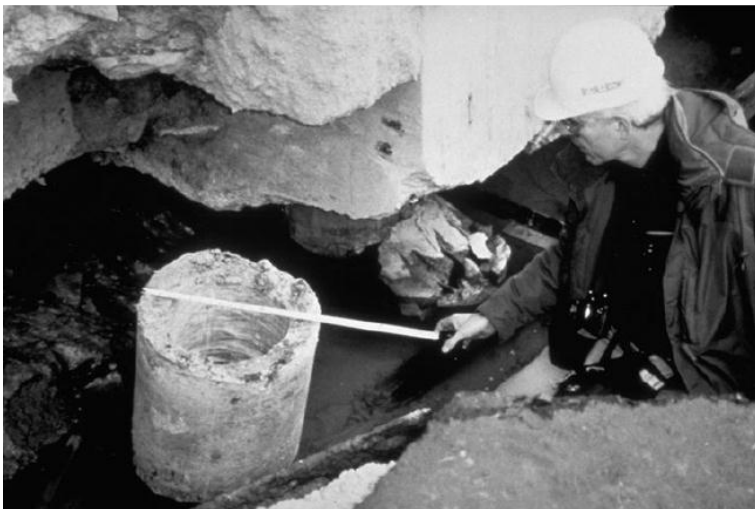
36. ábra: Az oldalirányú elmozdulások következtében tönkrement cölöpök. Kobe, Japán (1995)
