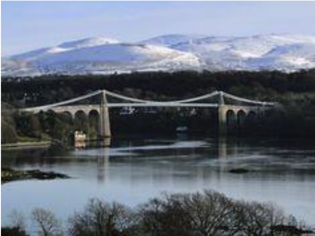
1. kép Menai Suspension Bridge
