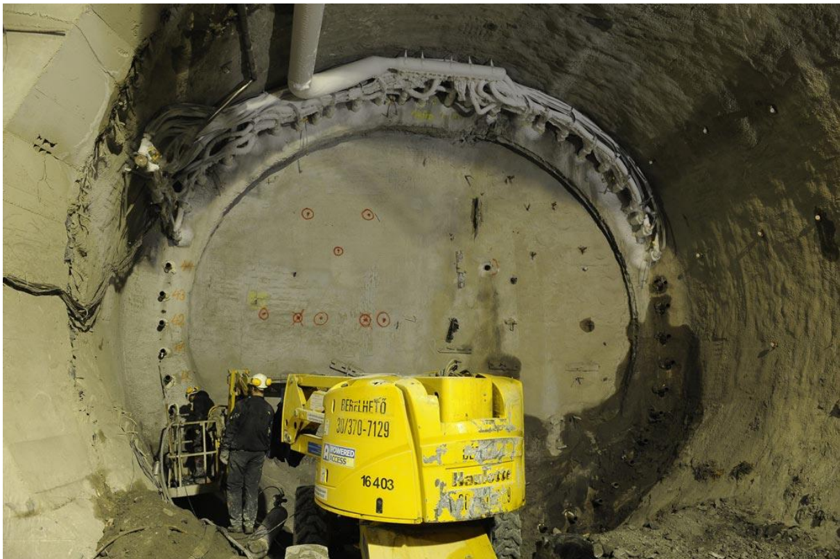
Talajfagyasztás az M4-es metró építése során. (fénykép: Wallis, 2009)
