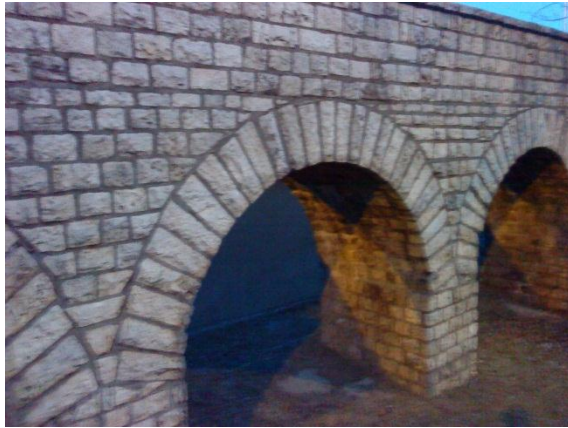
8. ábra. Az aquincumi vízvezeték maradványa
