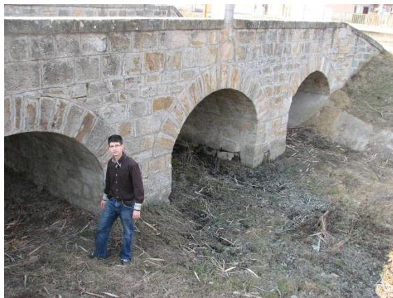
9. ábra. A romhányi háromnyílású homokkő híd
