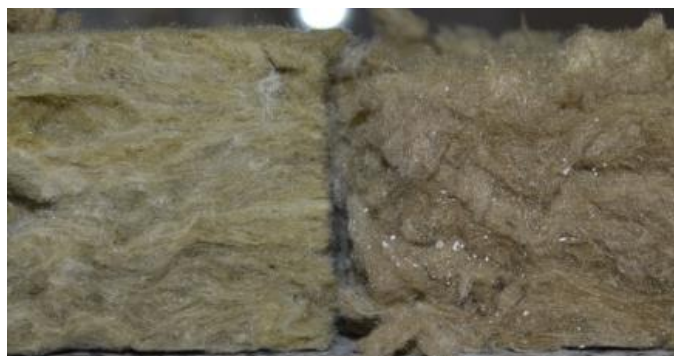
4.7 ábra: Leromlott kőzetgyapot hőszigetelés.
