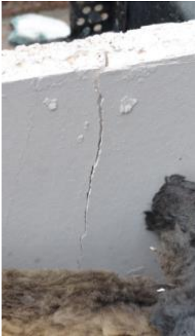
4.12 ábra: Tűzálló gipszkarton lap berepedése
