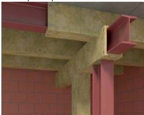
2.19 ábra: Kőzetgyapot tűzvédelemmel ellátott acél szerkezet [12]
