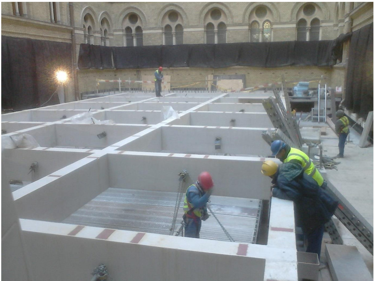
1. A kazettás mennyezet szerelés közben
