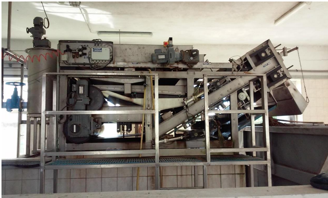
1. kép: Iszapvíztelenítő szalagprés a solymári telepen (készítette: Berecz Vivien, 2015. 09. 16.)
