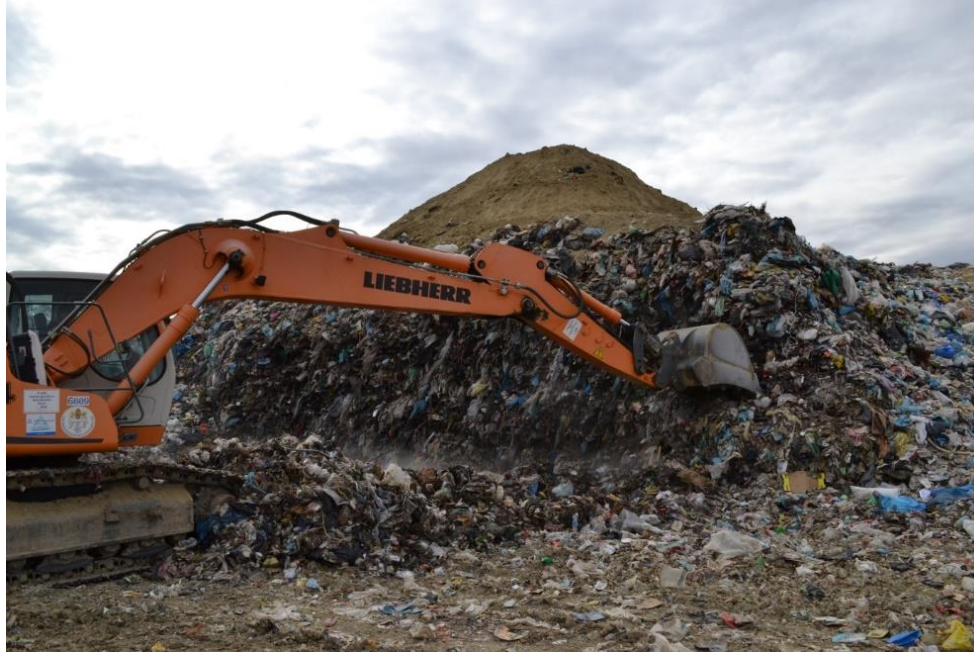
25. ábra: A rézsúláb kotrása
