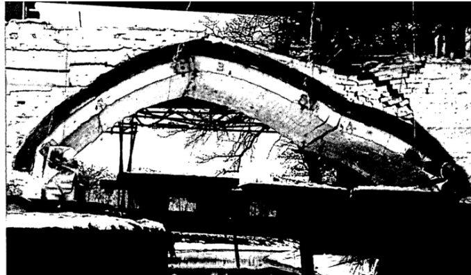
22. ábra – Prestwood Bridge tönkremenetel állapota [31]
