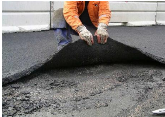
100. ábra: A rétegek tapadásának hiánya
