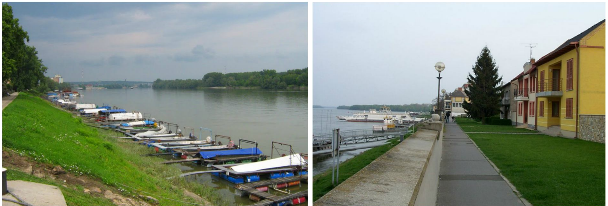
22. kép: Külvárosi és belvárosi rakpart Mohácson / Embankments at the outskirts and downtown in Mohács
