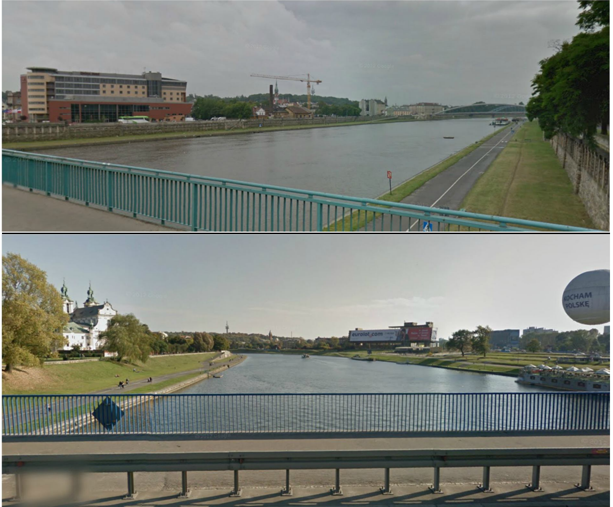
20. kép: Kilátás a rakpartokra a belvárosi szakaszon / View of the Embankments in the city
