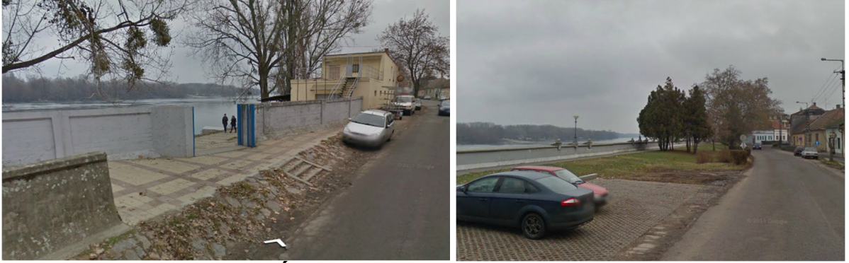
23. kép: Árvízi védőmű a felső rakparton / Flood-defense on the upper Embankment
