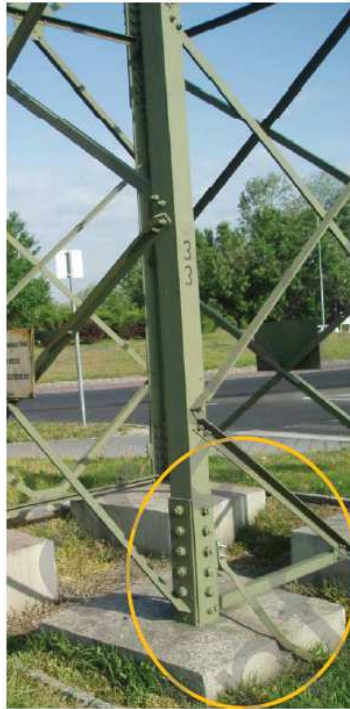
2. ábra Négyöví szögacél szelvényű tornyok kapcsolatai [3]
