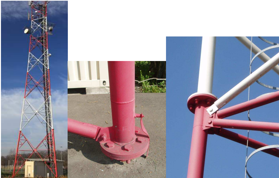
3. ábra háromvű torony kialakítás [3] 4. ábra háromvű torony csomóponti kapcsolatai[3]
