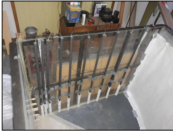
1. Kép: Megfigyelőkutak beépítése
