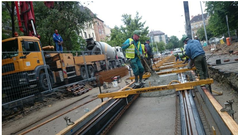
2.11. ábra: Budai fonódó villamospálya pályalemezének készítése [avers.hu]
