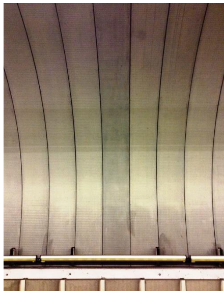
2.8. ábra: 4-es metró Fővám tér megálló beton panelek [készült: 2015.10.20.]
