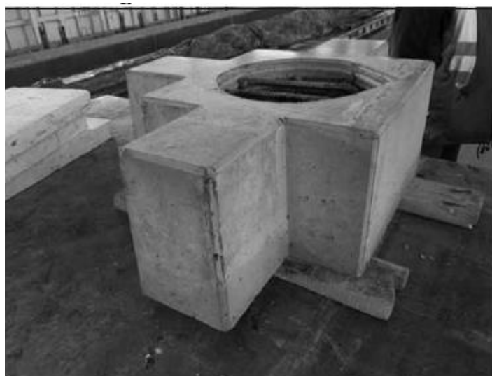
2.6. ábra: Debreceni Nagyerdei Stadion, előregyártott konzoltest [Dezső, Polgár, 2013]
