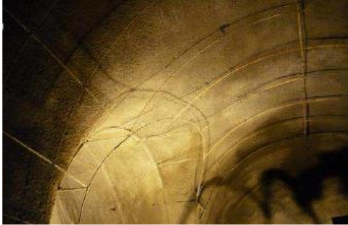
2.5. ábra: 4-es metró Rákóczi téri szellőző alagút [Pethő, 2013]
