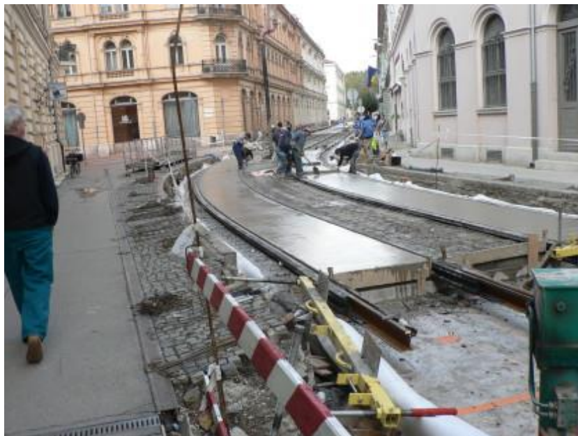
2.12. ábra: Szegedi villamospálya építése [fiberguru.hu]
