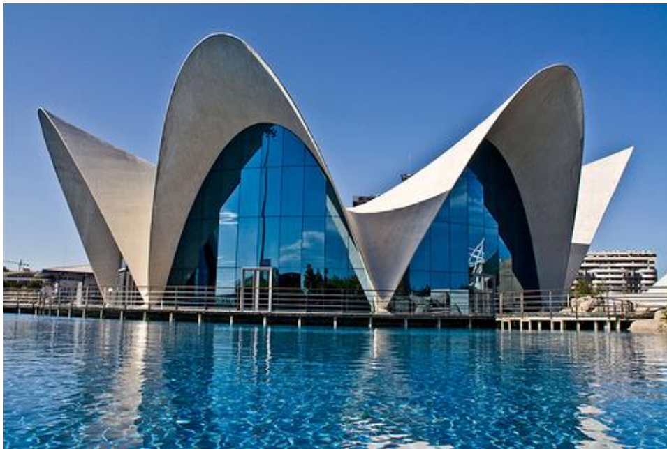
2.4. ábra: Acélszál-erősítésű héjszerkezet, Valencia, Spanyolország [c2.staticflickr.com]
