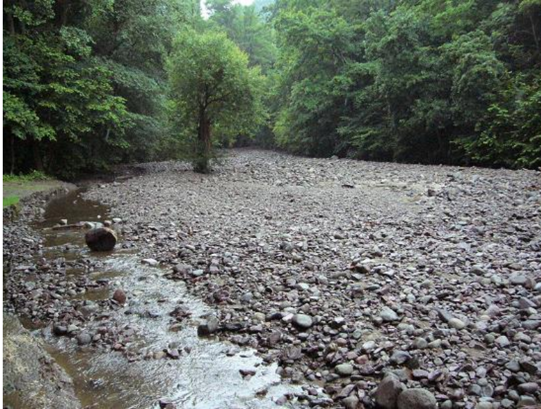
16. kép: Feltöltődött tározó, nagy szemcseátmérőjű hordalék (Műszaki leírás 2010)
