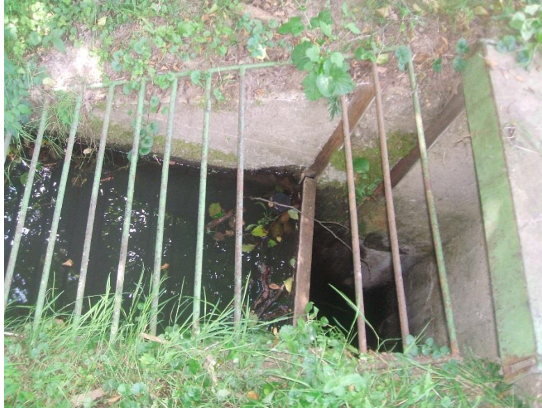
1. kép: Leeresztő műtárgy
