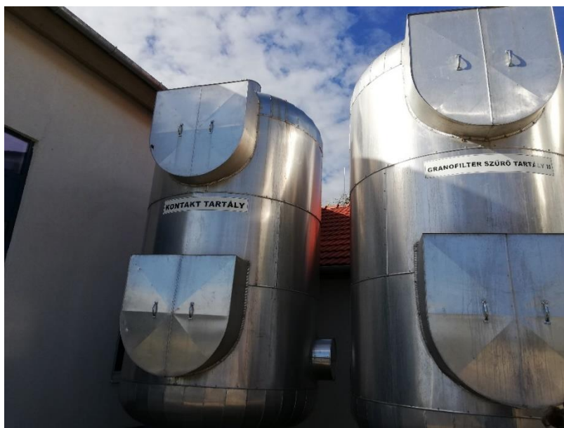
3.4-3. ábra Kontakt tartály és Granofilter szűrő
