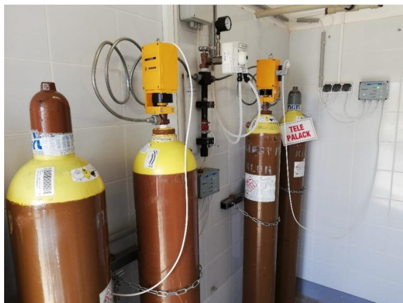
3.4-5. ábra Klórgáz tartályok és adagoló
