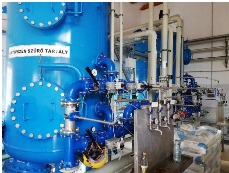
3.4-6. ábra Aktivszén adszorber, háttérben homokszűrő
