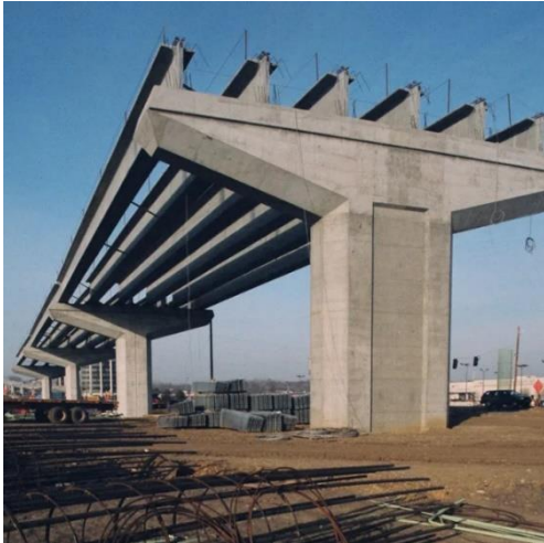
8. ábra: Sűrűbordás vasbeton híd építés közben
