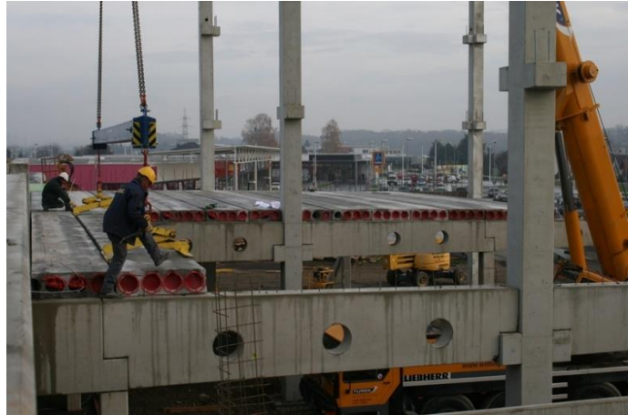
9. ábra: Üreges, előfeszített födempalló beépítés közben
