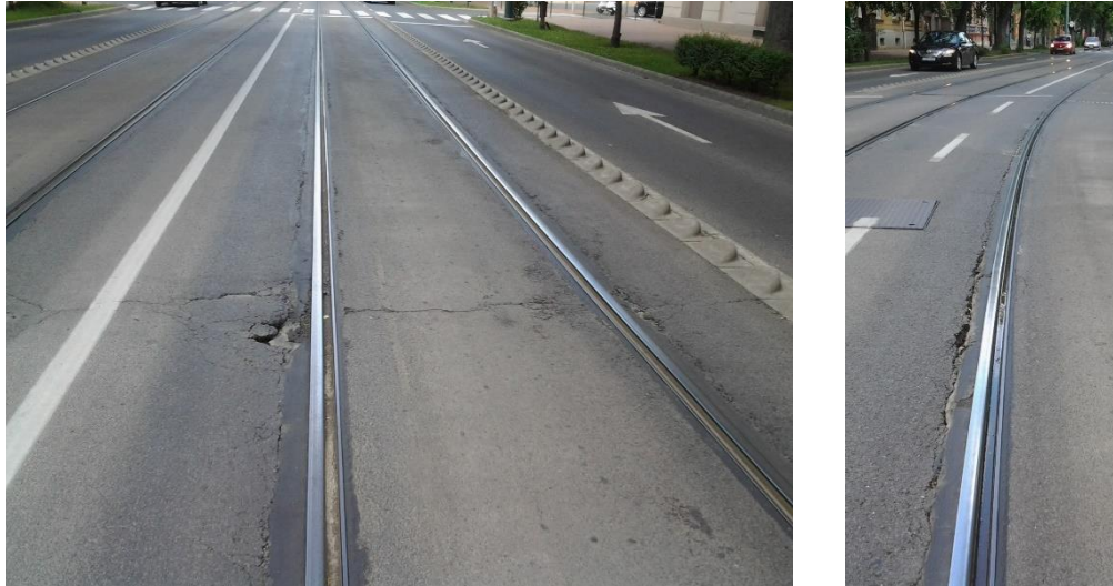
19. kép: Ortec Rafs pályaszerkezet károsodásai
