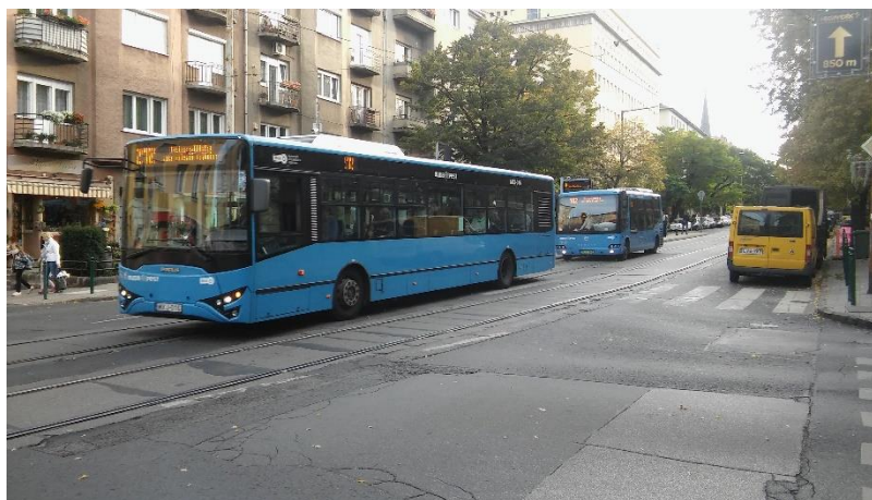
9. kép: nagypaneles felépítményi rendszer a Böszörményi úton
