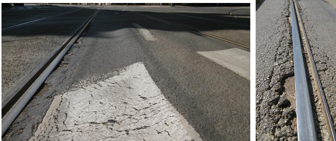
18. kép: nyomvályúsodás és a sínszál melletti károsodások az Anna-kúton
