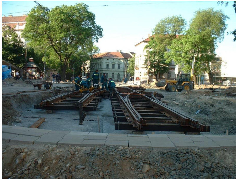
5. kép: bebetonozott talpfás kitérők építése Szegeden, a Dugonics téren (2002) [3]
