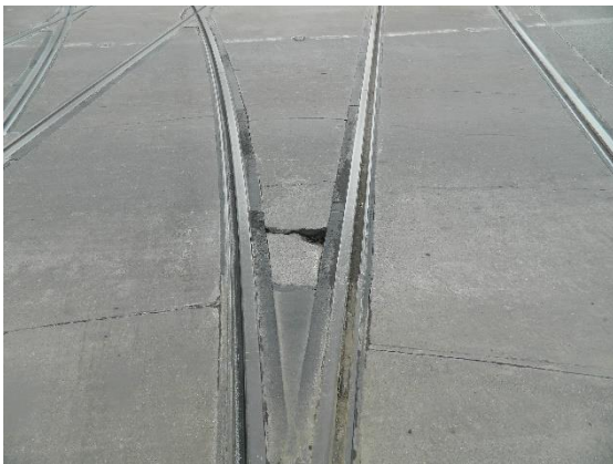
12. kép: keresztezési csúcsok közelében bekövetkezett beton tönkremenetel [3]
