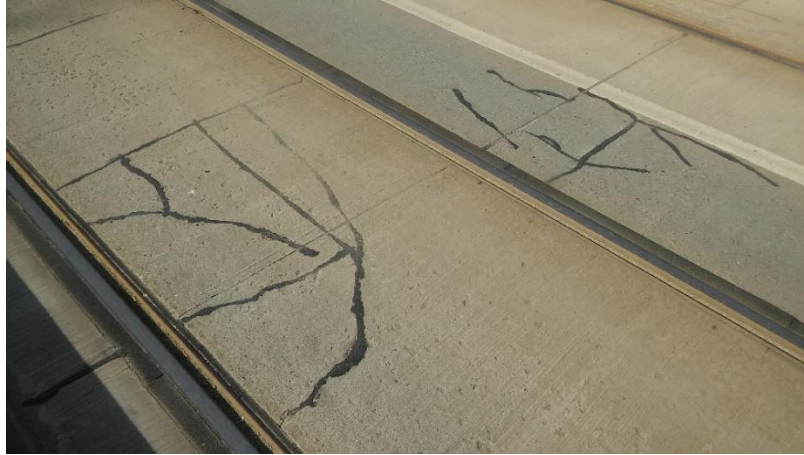
16. kép: folyamatos a repedésjavítás a bazaltbeton kopórétegen
