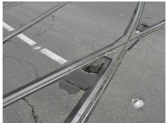
12. kép: keresztezési csúcsok közelében bekövetkezett beton tönkremenetel [3]
