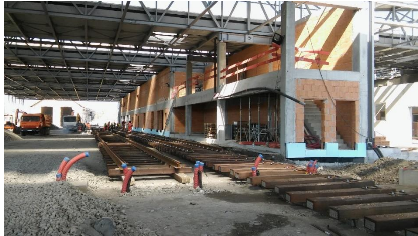
6. kép: bebetonozott talpfás vágány építése Budafok kocsiszíjben, 2017. március 17-én
