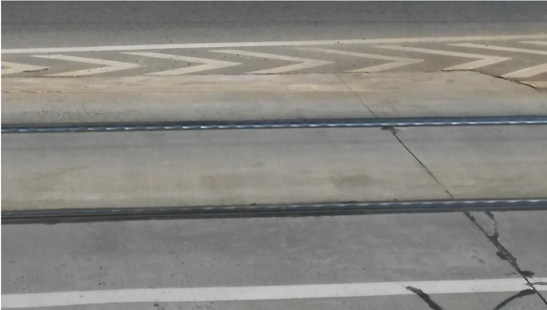
24. kép: hullámos sínkopás megjelenése Szegeden, a Damjanich utcai megállóhelyen
