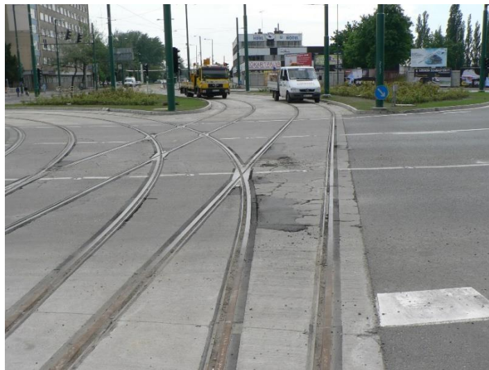
13. kép: csatornázott keresztező nehéztehergépjármű forgalom hatása a kopórétegre [3]
