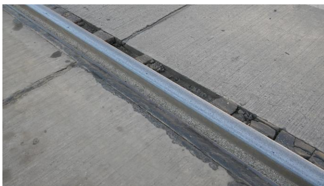
22. kép: fugaanyag merevedése és kitöredezése
