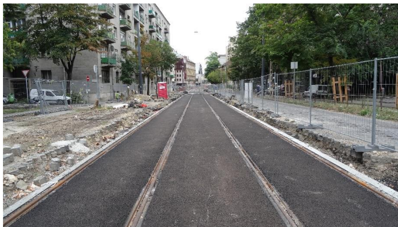
28. kép: aszfalt kopóréteg, alatta szálerősített pályalemez [6]
