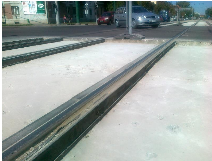
23. kép: sérülésmentes pályalemez CDM felépítményi rendszerben
