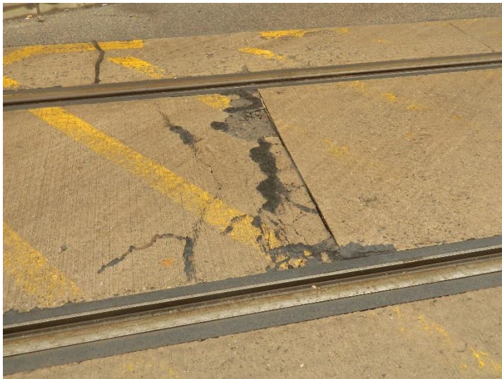
17. kép: bazaltbeton burkolati hibák a Glattfelder Gyula téren [3]
