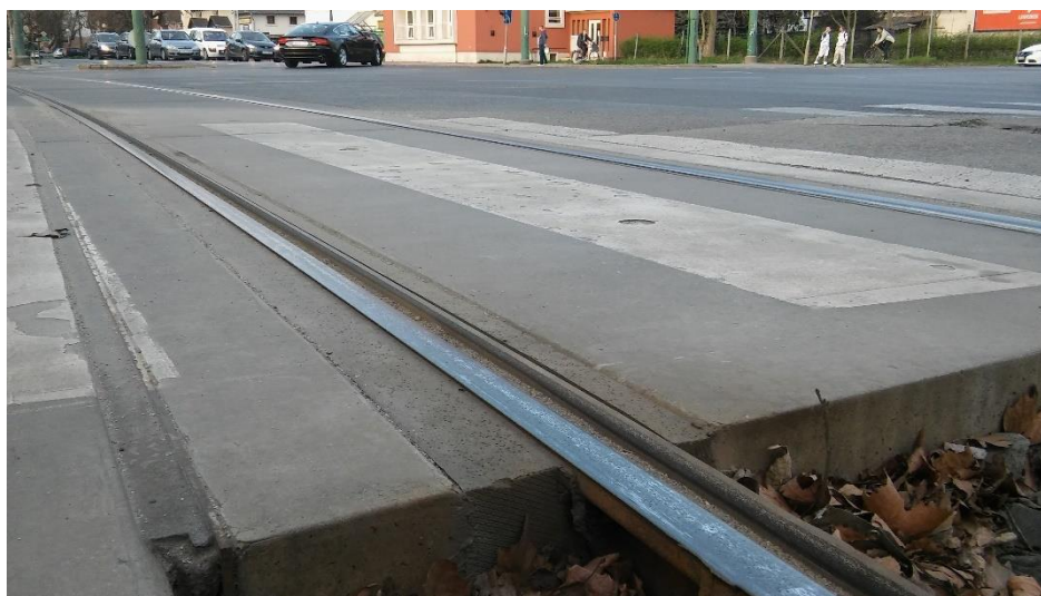
8. kép: sínkörülöntéses, nagyelemes útátjáró Szegeden
