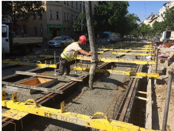
27. kép: pályalemez készítése a Bartók Béla úton [6]
