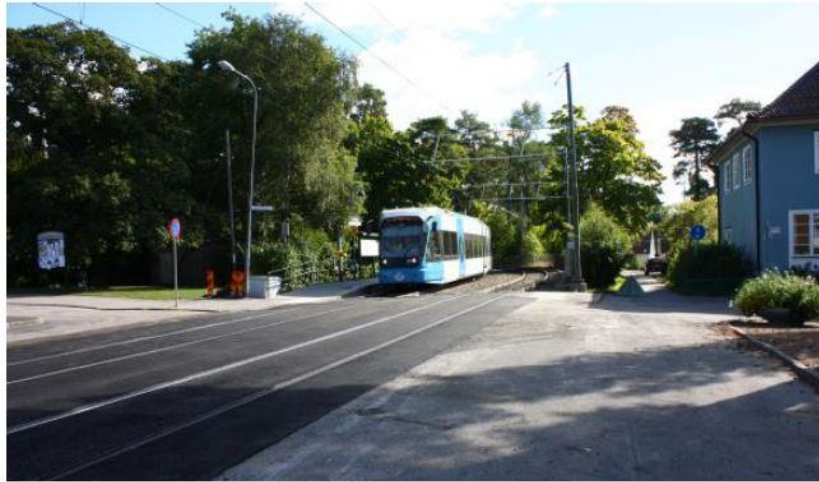
31. kép: közúti vasúti pályaszerkezet aszfalt burkolattal (Bromma, Svédország) [12]
