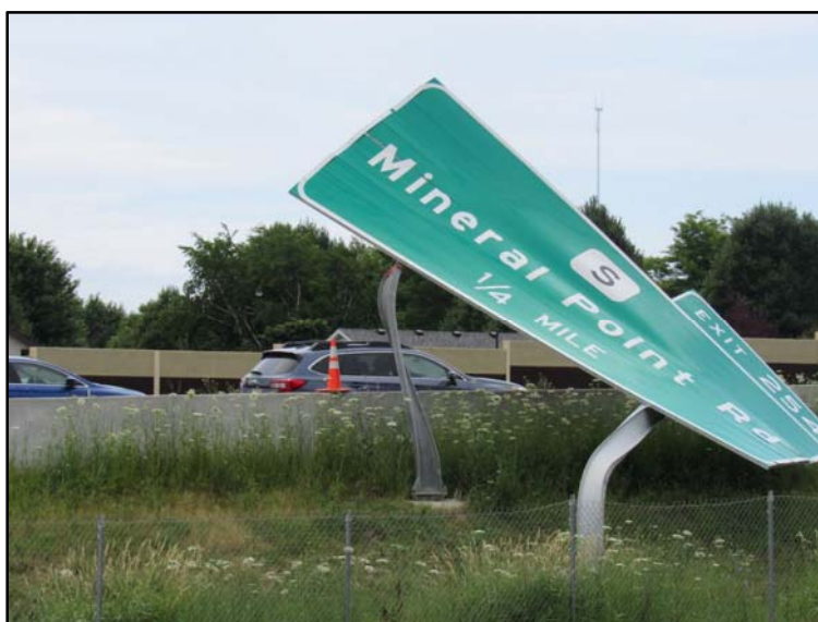
7. kép Szél által elhajlított portáltábla Wisconsin déli részén (Egyesült Államok), 2016.07.06-án 61
