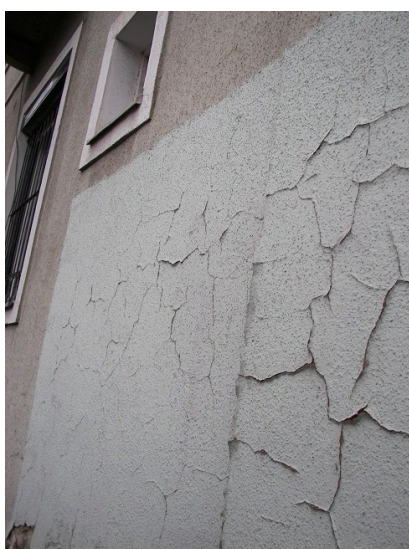
9. ábra: Nem megfelelő javítás [fotó: tulajdonostól]
