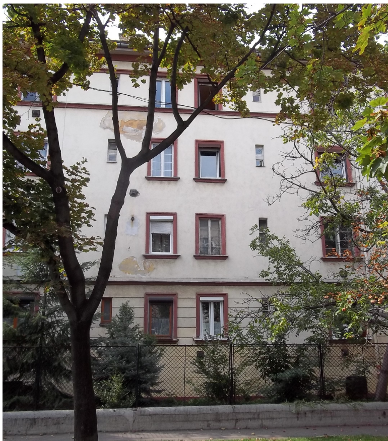
30 ábra: Bocskai út 43-45 szám alatti épületegyüttes homlokzat [fotó: Ress Mátyás]
