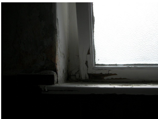
7. ábra: Nyílászáró szerkezetének károsodása [fotó: tulajdonostól]
