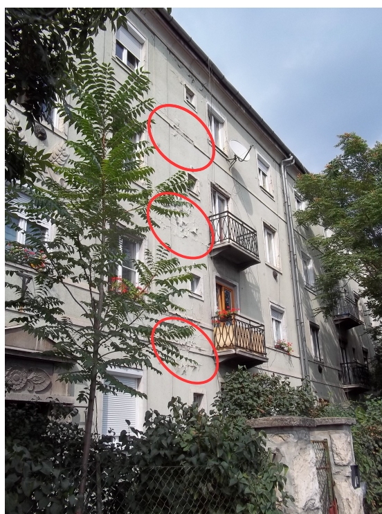
5. ábra: Átvizedés jelei [saját fotó]
