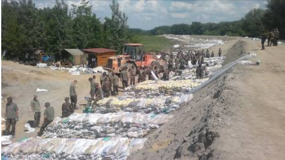
Bordás megtámasztás Győrújfaluban
