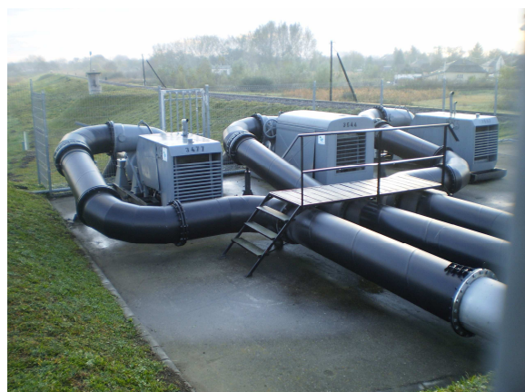
9. ábra: A víz átemelését és pótlását szivattyúk biztosítják
