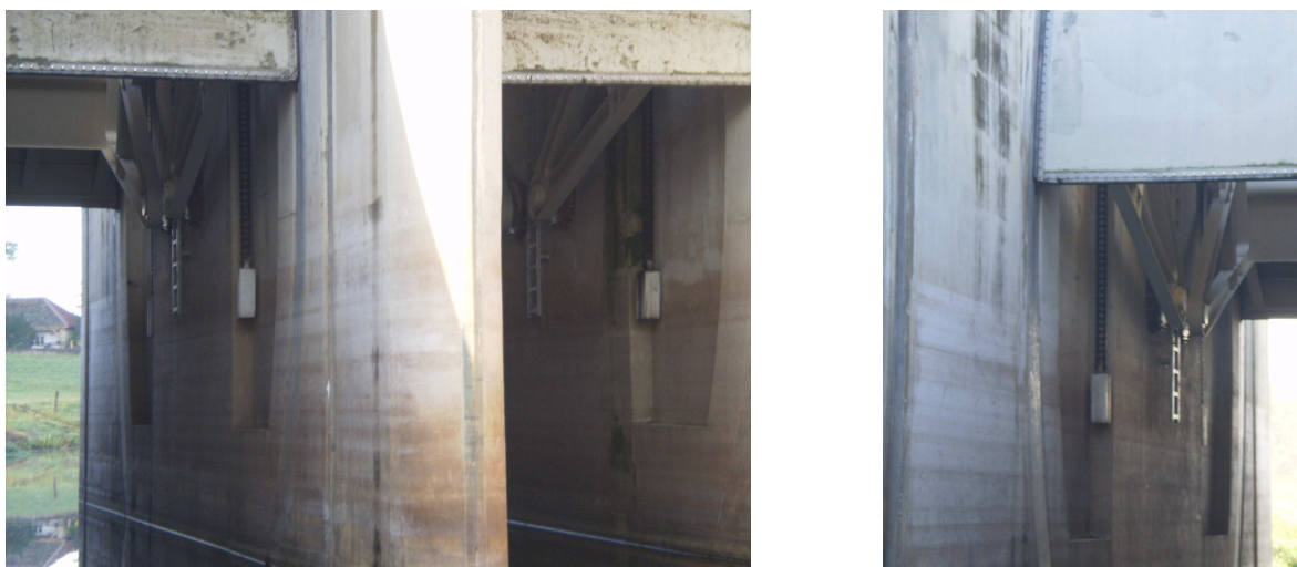
5. ábra: Az íves szegmensek erőátadása karokon keresztül történik a hengeres csapámaszra
