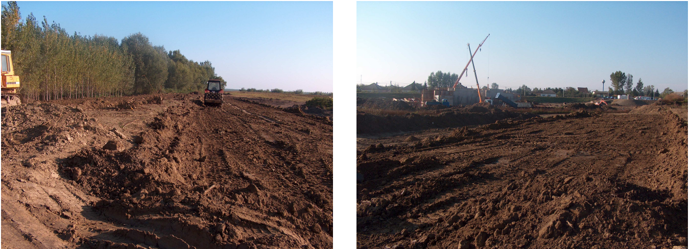
14. ábra: Töltésépítés (forrás: FETIVIZIG)
