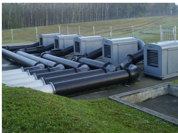
9. ábra: A víz átemelését és pótlását szivattyúk biztosítják
