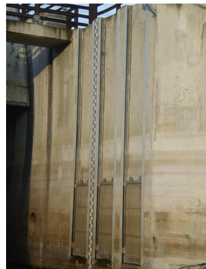
7. ábra: Ideiglenes elzárások tokszerkezetei (forrás: FETIVIZIG)
