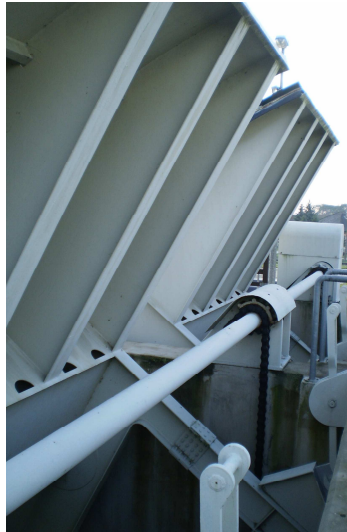
6. ábra: A szekrénytartóként kialakított elzárás mozgatása csapos teherláncsal történik
