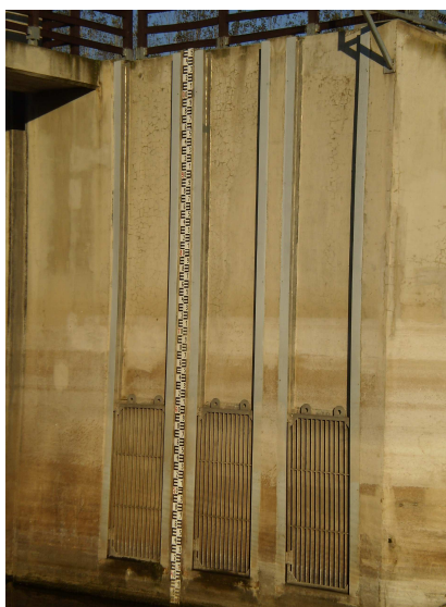
11. ábra: Vízállásészlelés rézsús és álló lapvízmércén, talajvízszint figyelő kút
