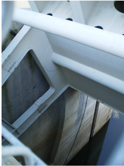
6. ábra: A szekrénytartóként kialakított elzárás mozgatása csapos teherláncsal történik
