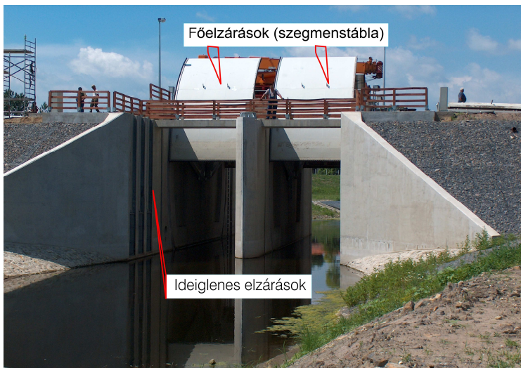
7. ábra: Ideiglenes elzárások tokszerkezetei (forrás: FETIVIZIG)
