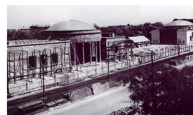
4.19. ábra. A Népstadion régi állomása [32]. Az állomás építése 1952-ben kezdődött, majd kb. 70%-os késziségnél 1954 elején az egész metróépítkezést leállították, az épületet visszabontották.
