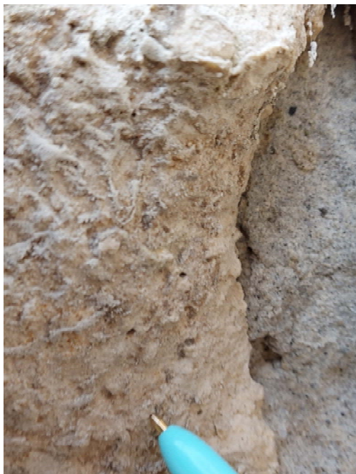
7.7. Levált mállási kéreg alatti fellazult zóna
