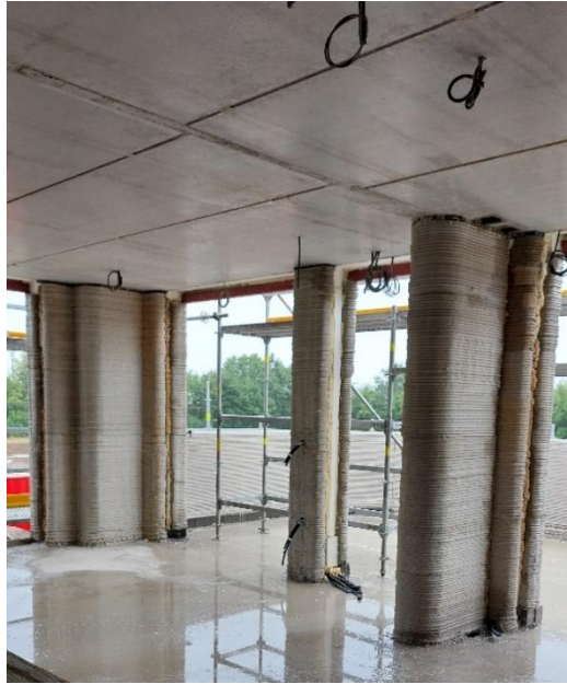
1. ábra: 3D betonnyomtatott épület födémrendszere kéregpaneles technológiával
