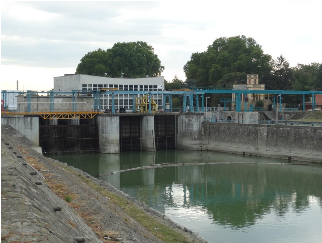
2. ábra (A műtárgy a felvíz felől)
